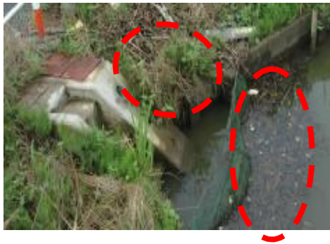
土砂、ゴミ等による取水阻害
