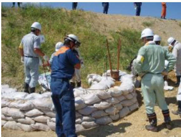
土のう作成・設置の訓練の事例
