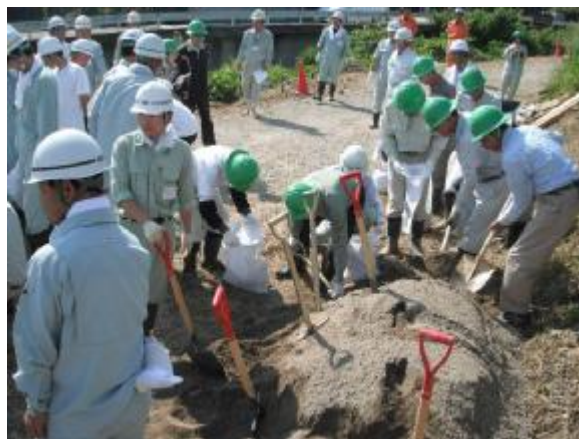
土のう作成・設置の訓練の事例
