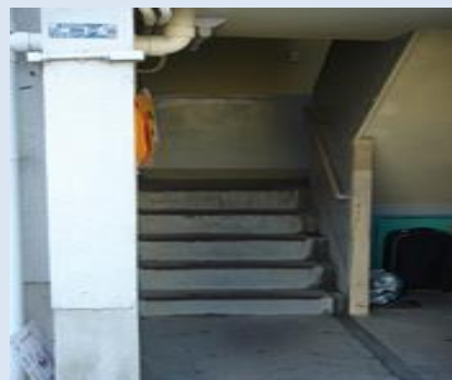
(共用廊下等への手摺設置例)
