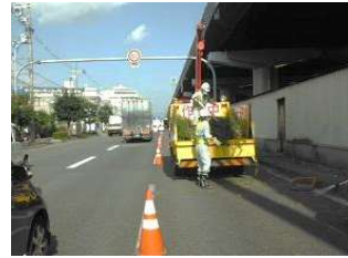
道路施設の清掃
