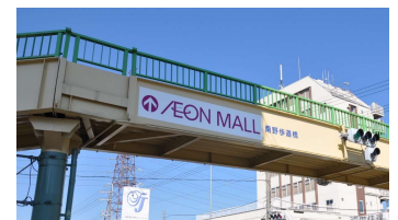
国道 170号 南野歩道橋（四條畷市）
