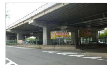
国道 423号 榎坂高架橋下（吹田市）
