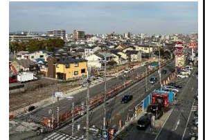
〔道路の整備（4車線化）〕
