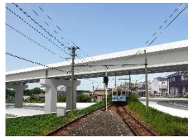
〔道路と鉄道の立体交差〕
