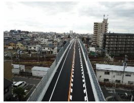
〔道路と鉄道の立体交差〕
