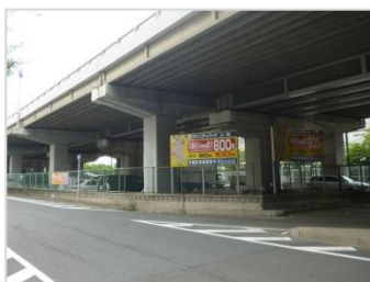
▲国道423号榎坂高架橋下 (吹田市)
