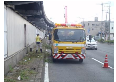
道路施設の清掃
