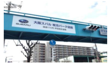
▲一般国道170号 伊加賀歩道橋(枚方市)
