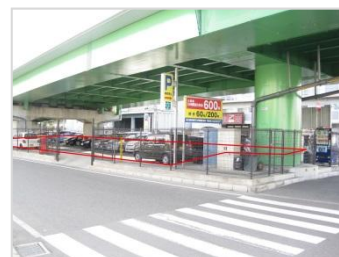
▲国道170号新町跨道橋高架下 (東大阪市)
