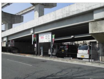
▲〔府〕茨木摂津線清水高架橋下 (茨木市)
