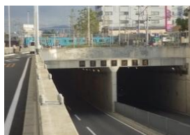
〔道路と鉄道の立体交差〕
