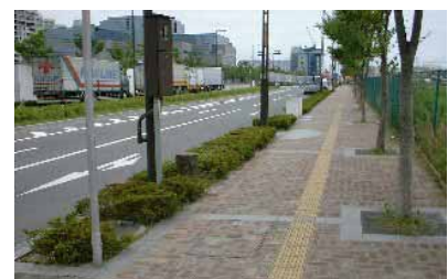
視覚障害者用誘導ブロック
