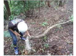
木の伐採作業
