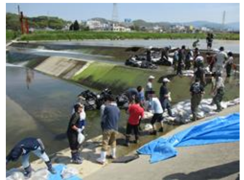
約20kgの土壌をバケツリレーで積み上げました！
