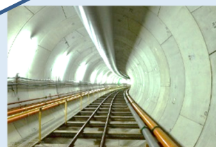
▲中央北増補幹線（R1.8供用）
