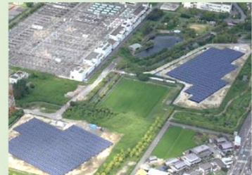
▲太陽光発電事業(渚水みらいセンター)
