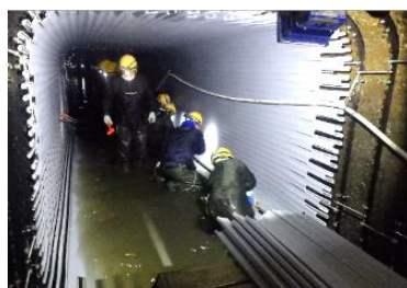
写真7 管渠の改築更新の例
