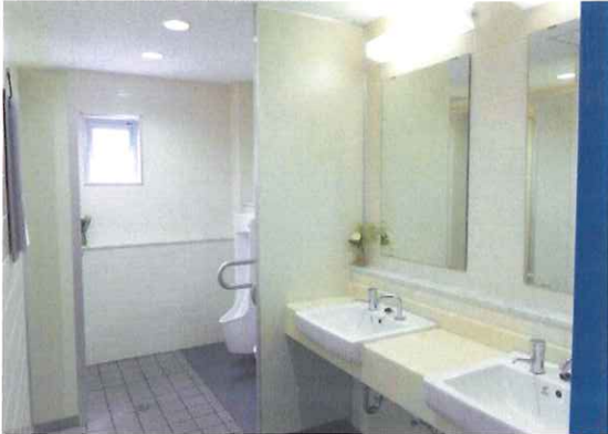
4-① ◆トイレ改修【内部1】
