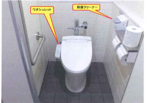
4-① ◆トイレ改修【内部2】
