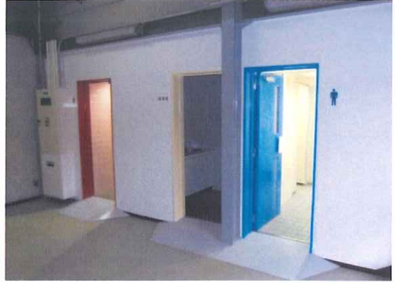
4-① ◆トイレ改修【改修後】
