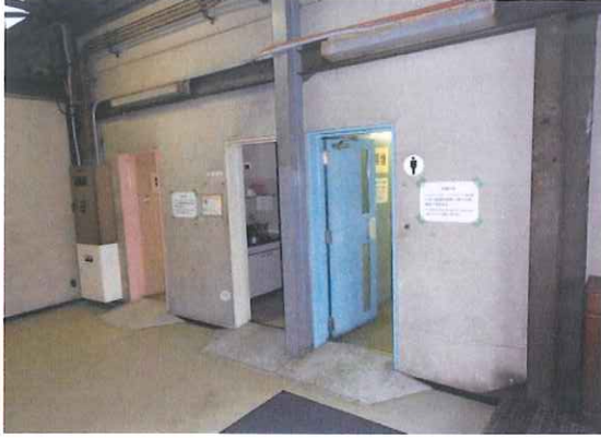
4-① ◆トイレ改修【改修前】
