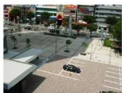
透水性・保水性舗装
