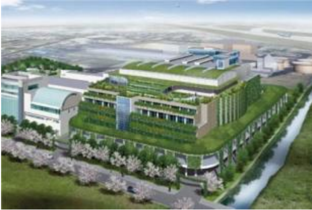
写真3 豊中市伊丹市クリーンランド
