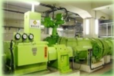
村野浄水場における小水力発電
