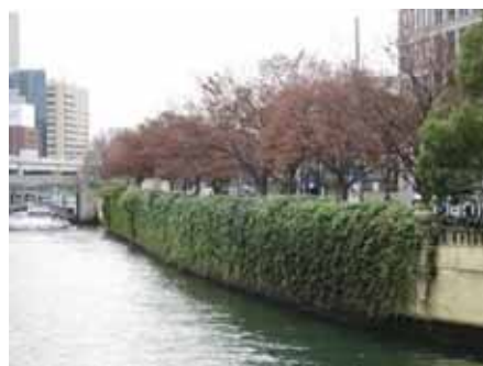
<護岸の壁面緑化>
