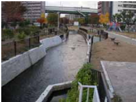
<長瀬川地区(東大阪市)での整備状況>
