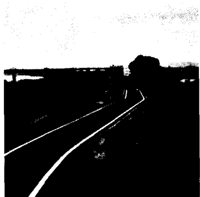
自転車周遊道路（守口市）
