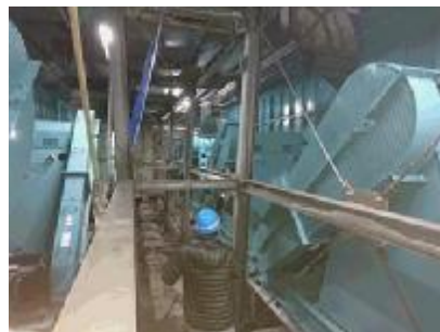
【更新後の冷却塔用排気ファン】
