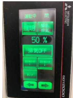
【排気ファン出力が上がると赤く表示。研究員に対しての意識付け】
