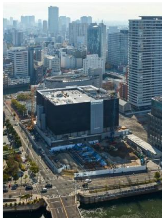
大阪中之島美術館 (建設中:令和4年春開館予定)
