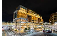
枚方T-SITEを眺める歩道橋
