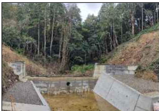
楠畑川第1支溪砂防事業
