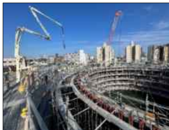
寝屋川北部地下河川城北立坑
