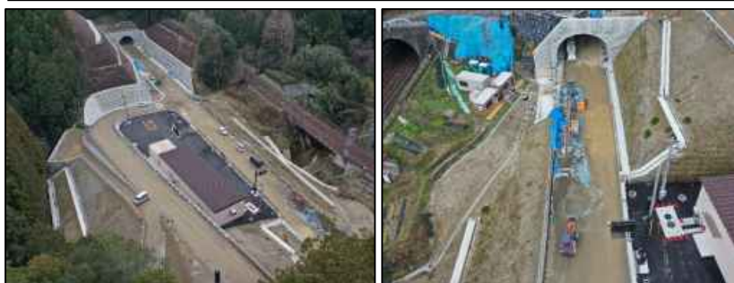
府県間トンネル部付近の現況
