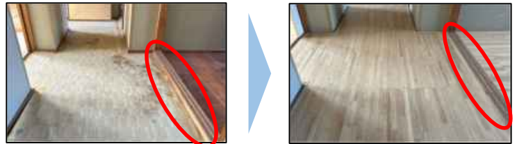
【バリアフリー化】床段差の解消
