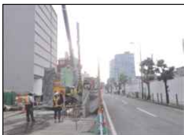
中之島駅部（土留め工）
