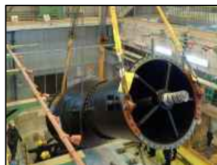
下水道施設の更新
