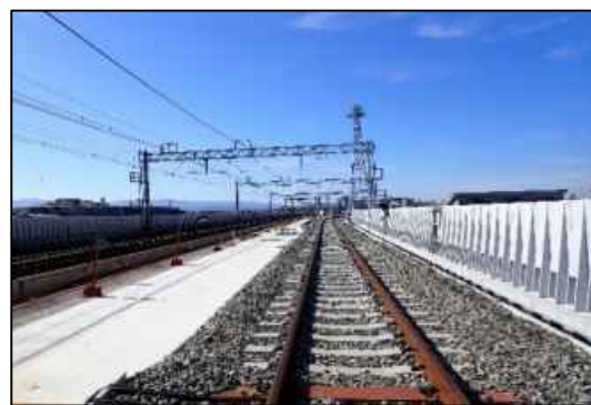
南海高師浜線 本線との分岐部付近（高架橋工事）
