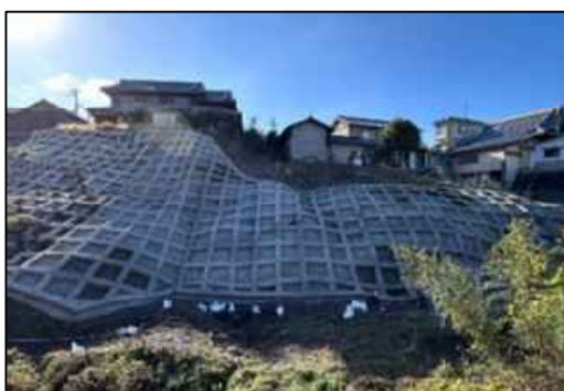
中佐備地区急傾斜地崩壊対策事業
