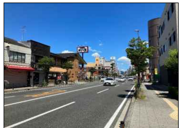
電線共同溝による無電柱化 【国道176号(豊中市)】
