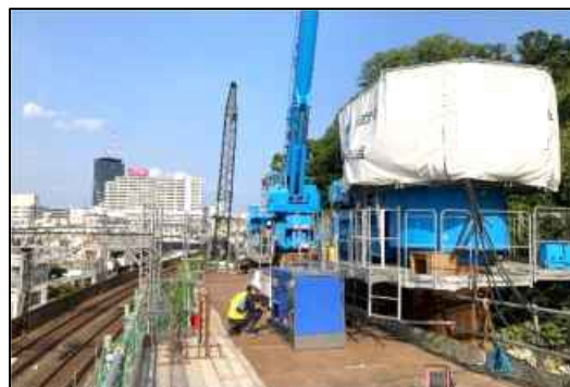
京阪本線 事業区間起点付近（土留工事）
