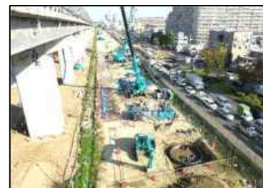
車両基地整備工事
