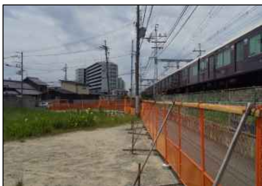
阪急京都線 摂津市駅付近（用地買収状況）
