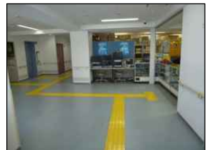
視覚障がい者誘導用ブロックの敷設
