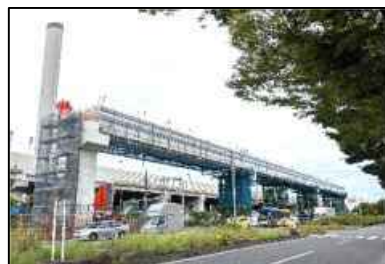
鋼軌道桁架設工事
