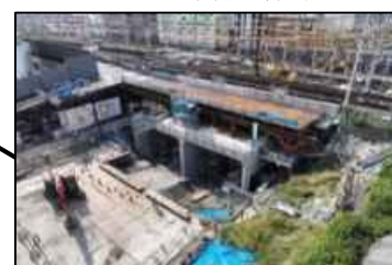
阪急電鉄直下のトンネル築造状況 【淀川左岸線（2期）】
