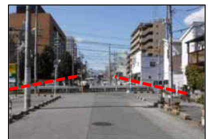
岸部南工区（阪急交差部）
