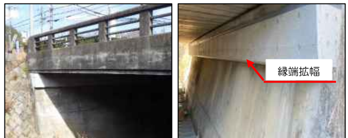
橋りょうの耐震対策（縁端拡幅） （過年度実施例：国道423号女美尾橋・豊能町）
