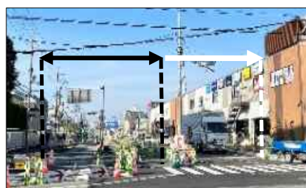
都市計画道路の整備による延焼遮断空間の確保 (三国塚口線)
