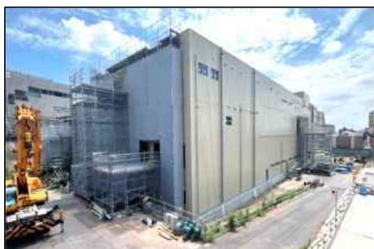
京阪本線 香里園駅（仮駅舎工事）
