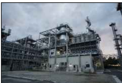
温室効果ガス排出量の少ない 次世代型焼却炉の導入
