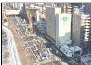
西本町駅部（道路占用状況）
