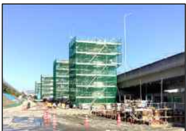
支柱建設工事
