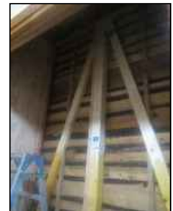
木造住宅 筋交い設置
