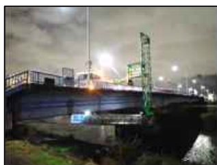
橋りょうの定期点検
