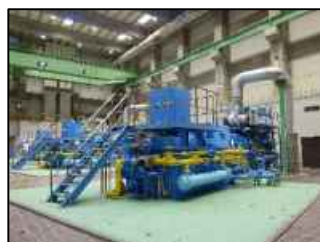
河川設備の長寿命化
