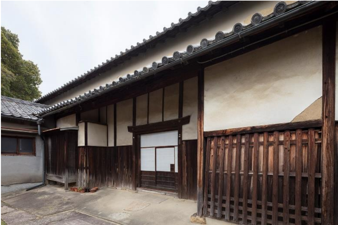
池守田中家旧宅 主屋入口【大阪狭山市提供】
