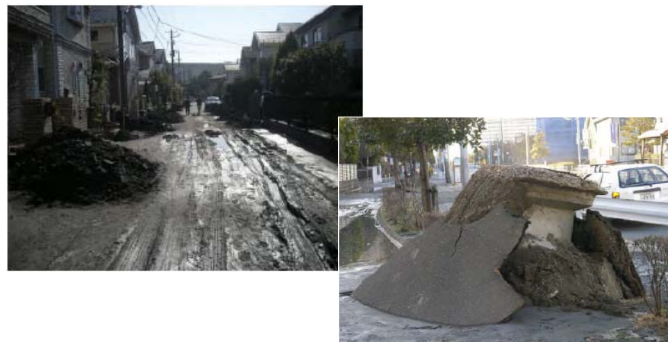
液状化の様子 「浦安市液状化対策技術検討調査委員会」第一回委員会資料より抜粋
