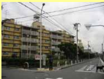
住棟と敷地周辺道路（南側）
