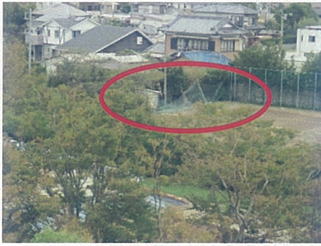
ネットフェンス倒壊
