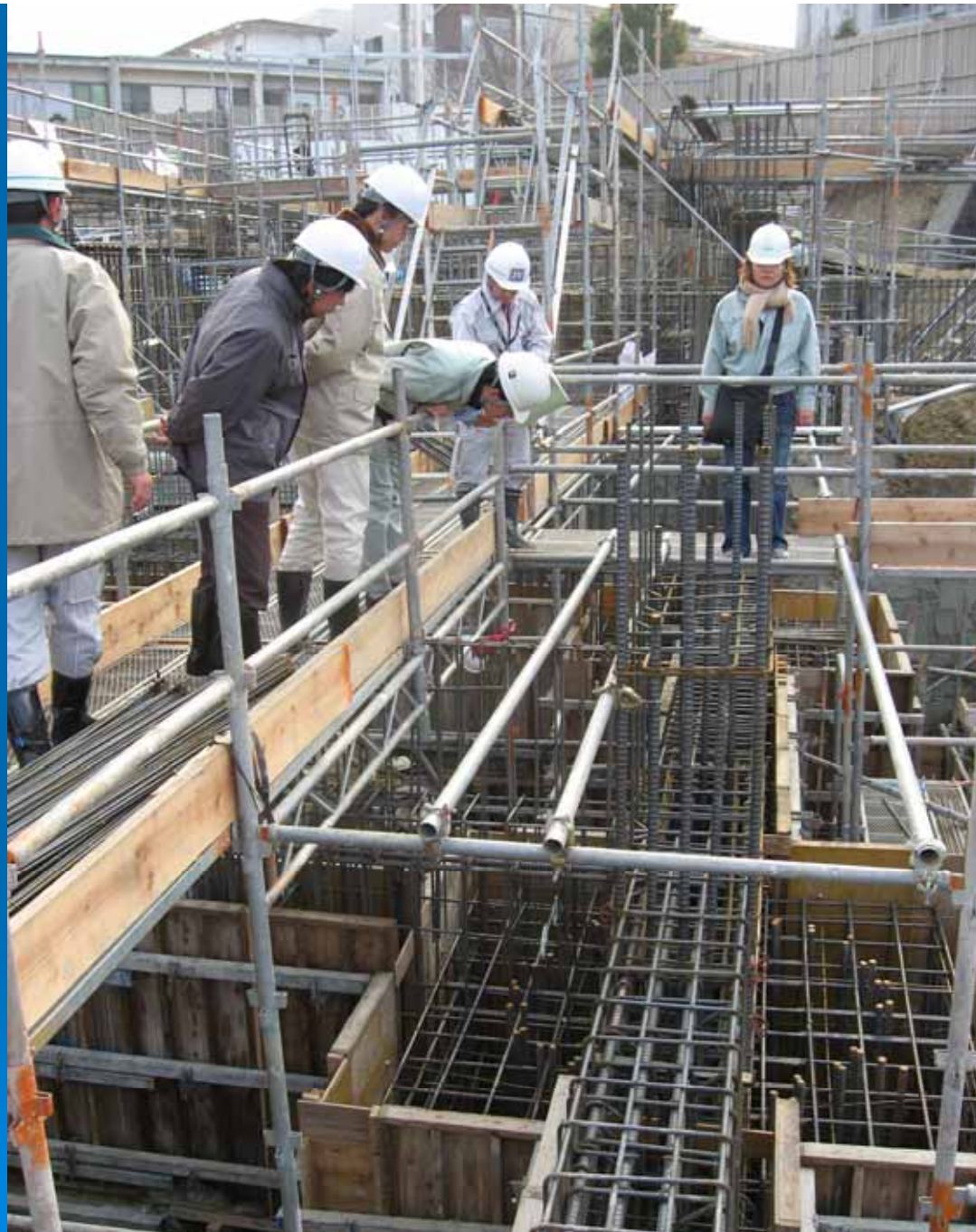
佐竹台住宅における建設工事のモニタリング
