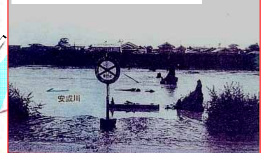
あけぼの橋流失(茨木市東野々宮町)
