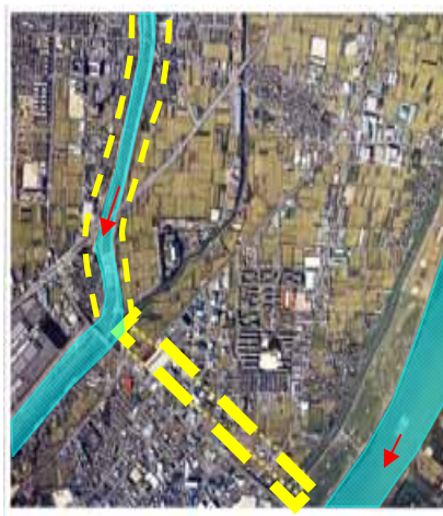
【河川改修 + 放水路】 安威川中流部
