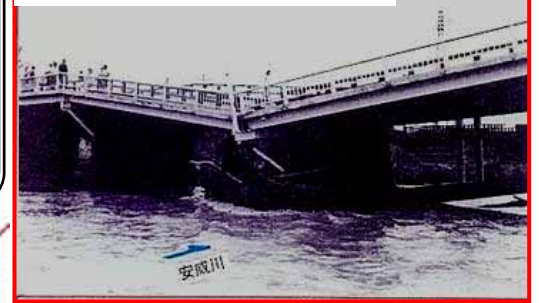
千歳橋の橋脚破損(茨木市戸伏町)
