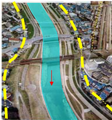
【河川改修】 安威川下流部(L=18km)
