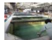
栽培漁業センターの水槽施設
