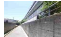
堺(出島)漁港の防潮堤
