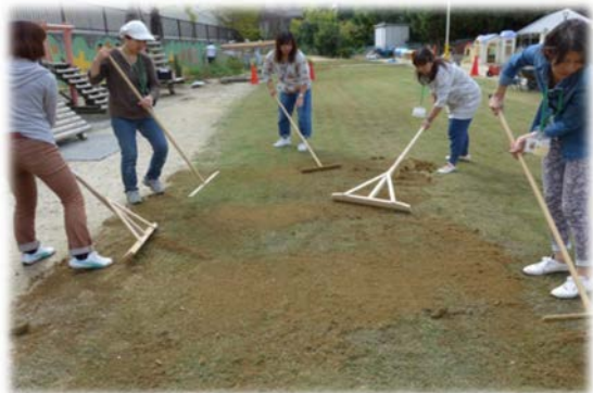
保護者の皆さんによる芝張り後の目地入れ
