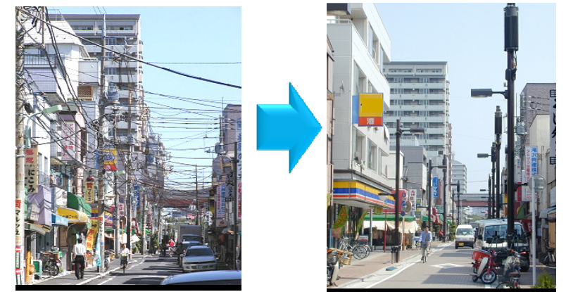
図5-3-4 無電柱化による都市空間の整備事例 (東京都江戸川区平井春日通)
