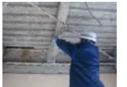
解体現場立入検査
