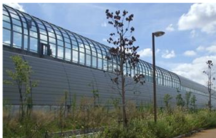
遮音壁の設置
