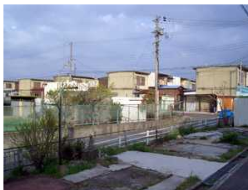
北西方より調査対象地
