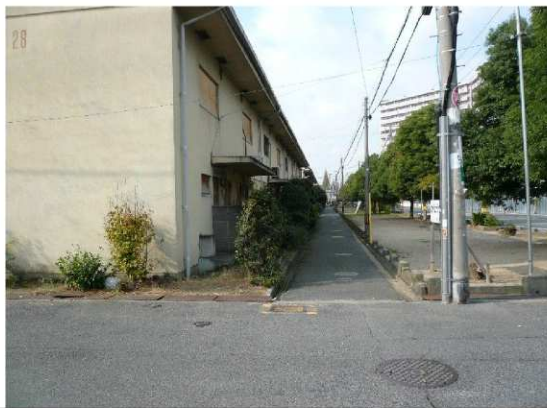
1. 北東角地(北側道路 東側から西側を望む)
