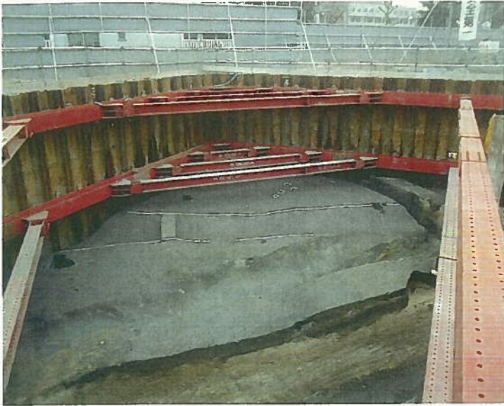
写真10 第8面西半西端 (北から)
