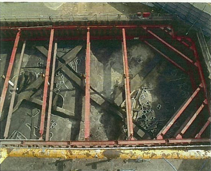
写真9 第7b面西半西側 (北から)
