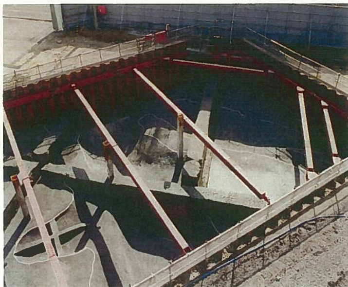
写真6 第6面西半西側 (北から)
