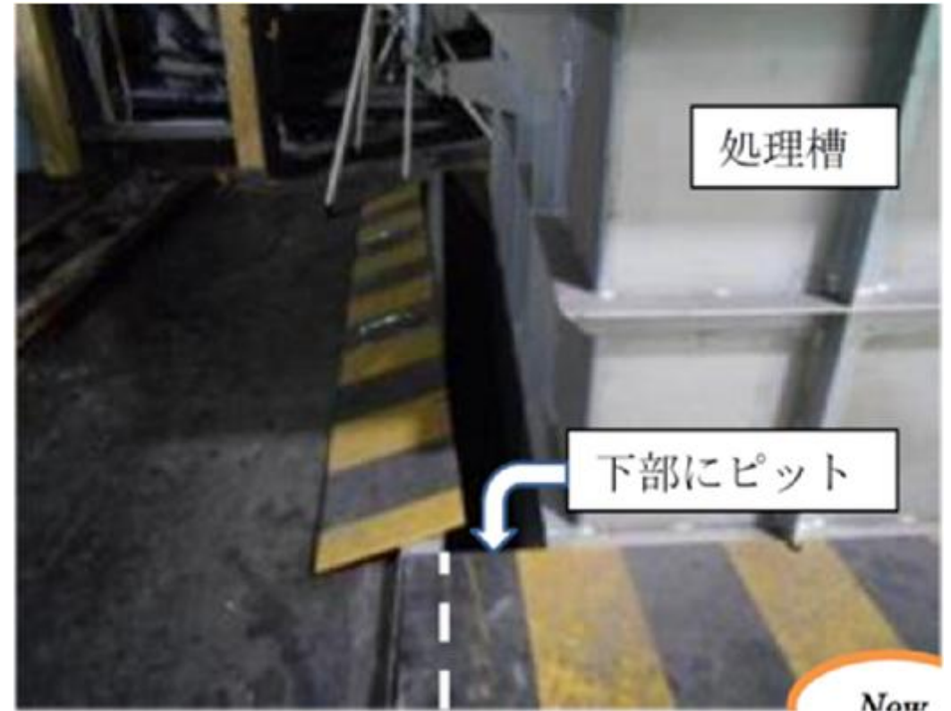
処理槽の二重構造化
