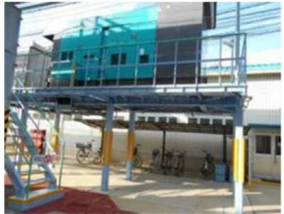
自家発電機のかさ上げ
