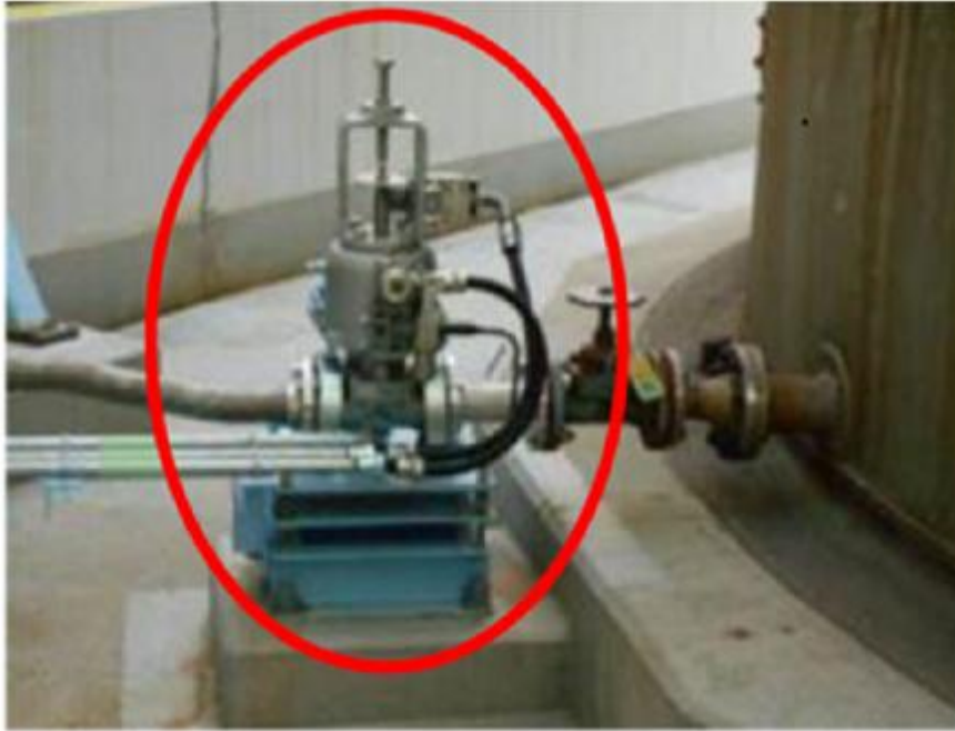
緊急遮断弁（地震計と連動）
