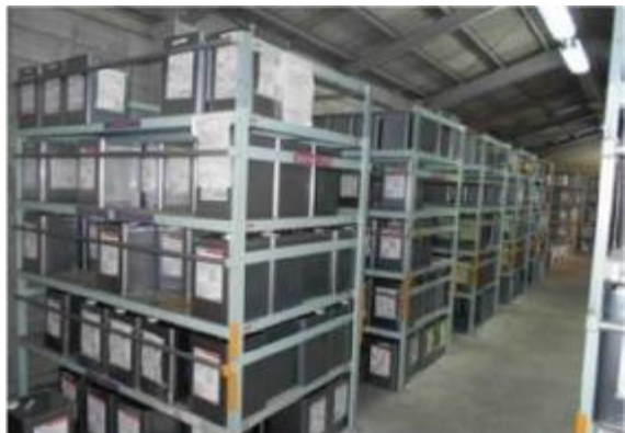
容器の固定 (棚のアンカー固定 + 転落防止柵)
