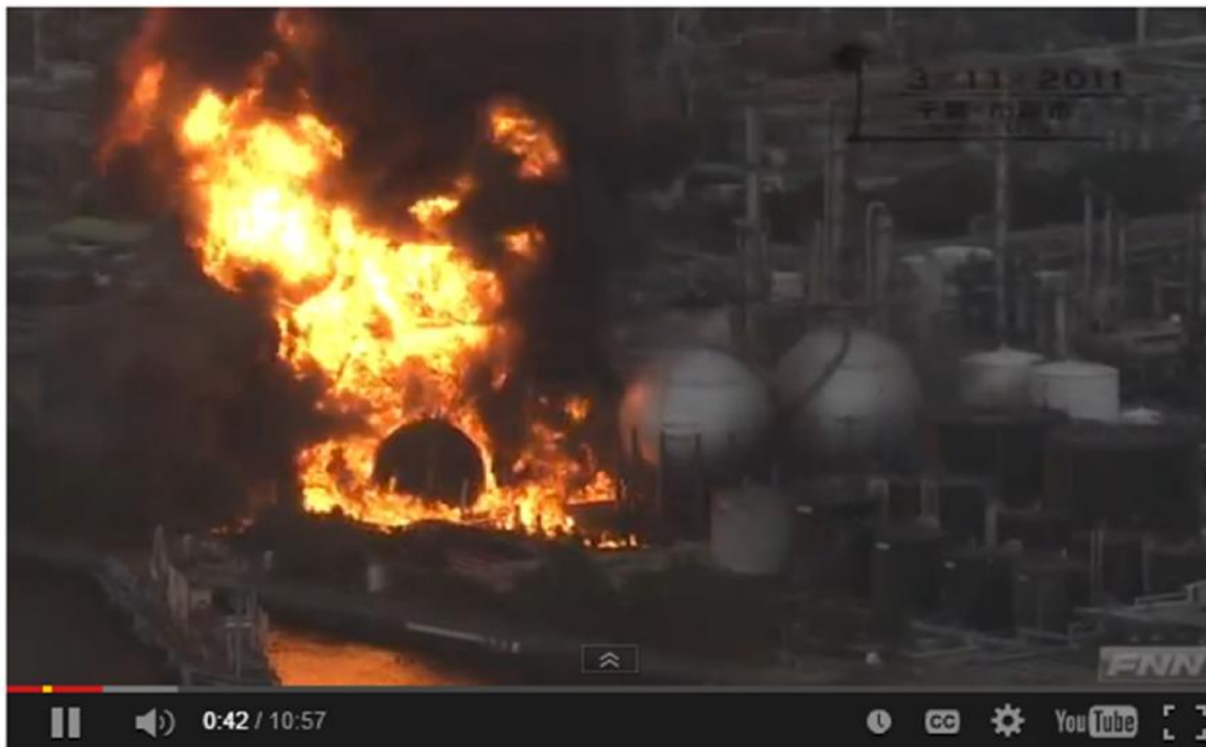
爆発炎上するコスモ石油千葉製油所のLPGタンク(2011年3月11日) フジニュースネットワーク (3.11忘れない)
