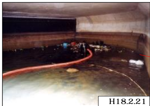
① 浚渫状況写真（新王子川）
