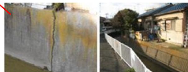
河川巡視点検の様子(H25) 出典：点検調書（河川巡視点検）
