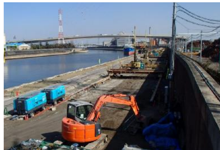
施工中(地盤改良工)
