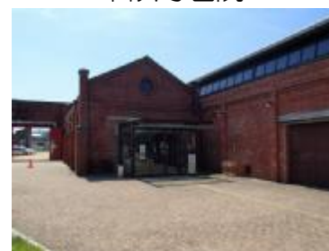
熊取交流センター煉瓦館
