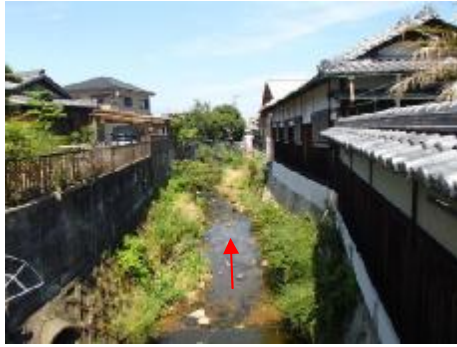
⑦ 紺屋上橋下流
