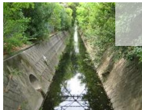
図 1.7 狭間川 （狭間小橋上流～府道大阪中央環状線）
