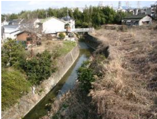
図 1.4 西除川（狭山池ダム上流）
