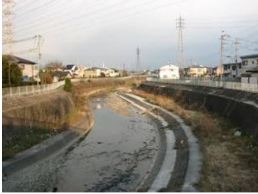
図 1.2 西除川（大和川合流点～南海高野線）
