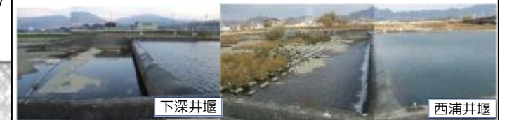
数多くある井堰により瀬切れが発生
