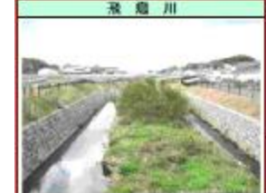
川幅は30m~10m 改修区間は環境に配慮した護岸を整備
