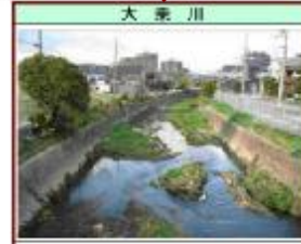
川幅は約20m 両岸にコンクリートブロック護岸が整備 沿川では市街化が進行
