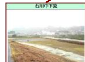
川幅は300~30m 護岸が整備された直線的な河道 堰による湛水域と砂礫の河原が見られる 高水敷きに河川公園が整備
