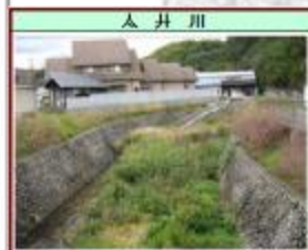
川幅は約10m 両岸にコンクリートブロック護岸が整備 沿川には住宅地と農地が広がる 河道内に瀬や淵が見られる 河岸に樹林が迫る
