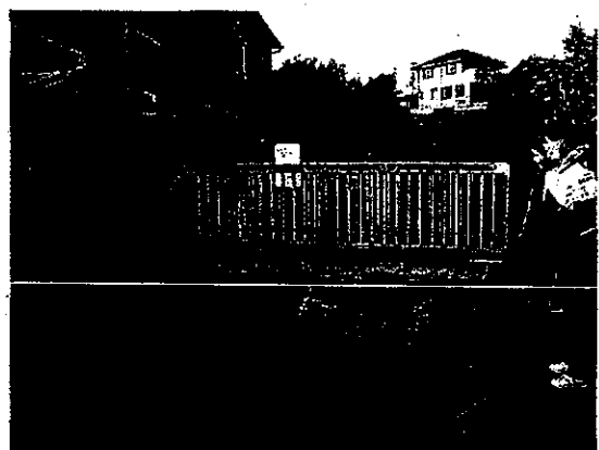
写真3 歩道橋上流から見た建物の状況 護岸の上に家が建っている。流下能力は小さいが、右岸の農地に氾濫するためか護岸は古いままである。拡幅の緊急性はない。
