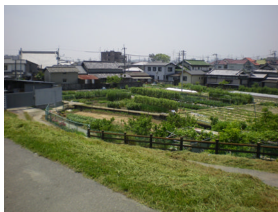
名神高速道路付近の堤内地側
