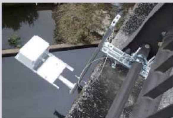
現場実証実験第一弾(鶴見川水系 烏山川)
